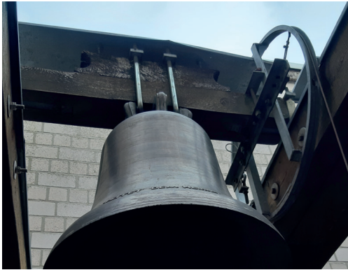
Glocken in Mainaschaff dem Wetter ausgesetzt
